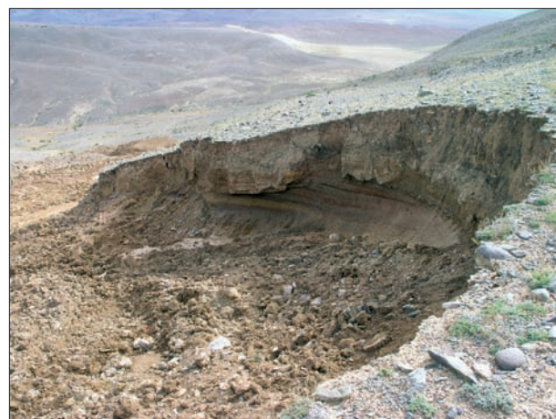
Рис. 4. Обнажение пласта льда в вершинной части надоползневой уступа (высота уступа 4–5 м).
